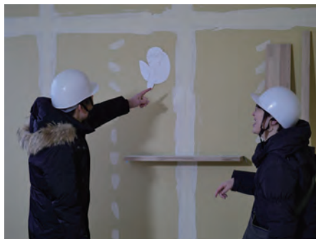
安置室ののりのいおり、レリーフの設置工事打ち合わせ
